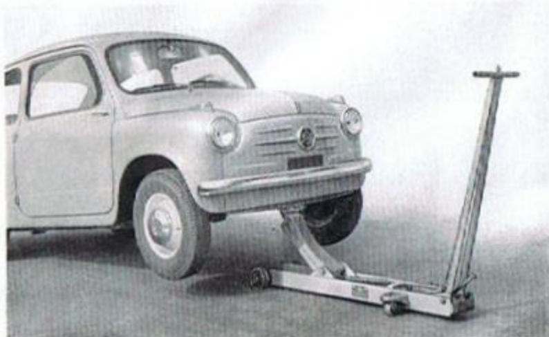
Fig. 53: Således løftes vognens forreste, når der benyttes en rullede donkraft.
